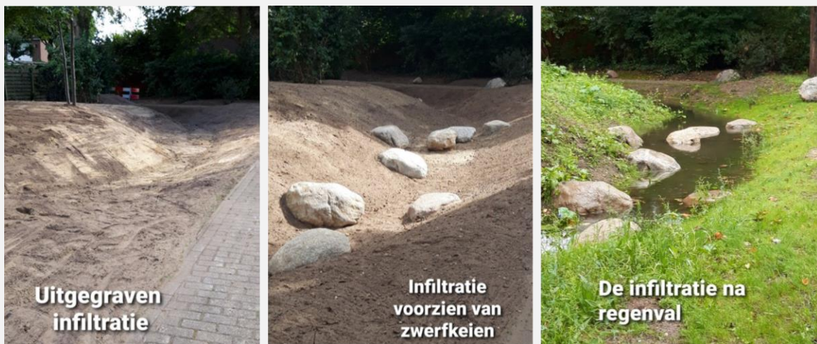
Figuur 2.4: Werkzaamheden van de wadi
