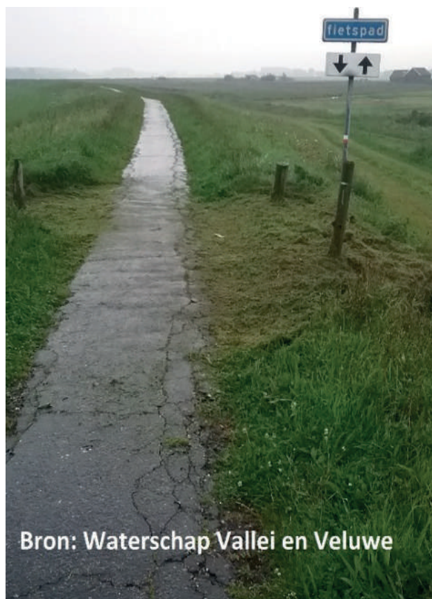
TOESTAND VAN ASFALT KAN GOED BEOORDEELD WORDEN
