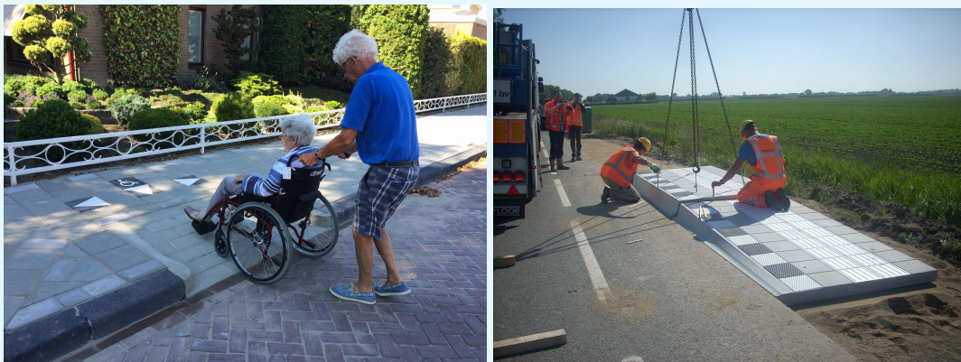
Figuur 11 en 12: Prefab trottoirafrit en bushalte.
