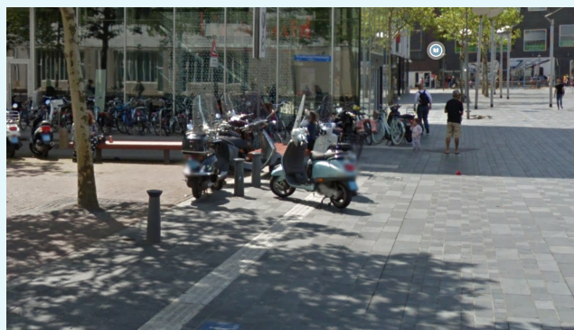
Figuur 8: Geleidelijn wordt geblokkeerd door fout gestalde voertuigen.
